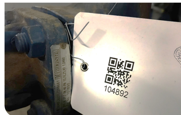
Abb. 7 | QR-Code mit ID-Schild an Typ und Hersteller für AS BUILT Aufnahme
