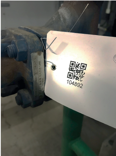
Bild 9: QR-Code mit ID-Schild an Typ und Hersteller für AS BUILT Aufnahme
